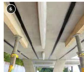
Figures 4 à 6 - Redressement d'un plafond en béton au moyen de lamelles de basalte (Abri pour vélos à Lyss).
