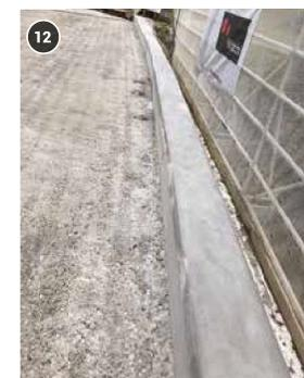
Figures 10 à 12 - Utilisation de renforts et d'étriers pour la réparation des bordures de pont (Pont de la route principale à Lützelflüh, 11<sup>e</sup> arrondissement d'ingénieur en chef, Service pour le Jura bernois ; Ingénieur responsable Hartenbach & Wenger AG.
