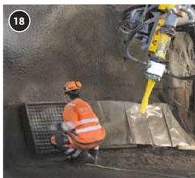
Figures 16 à 18 - Essais de béton projeté avec des grilles et des fibres de basalte (Strabag AG).
